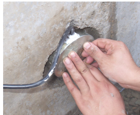
图 2 土压力盒嵌入预留孔内 Fig.2 A earth pressure cell in pore space
